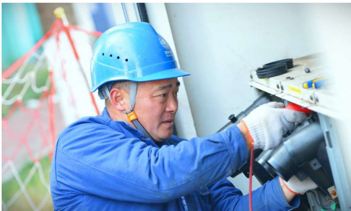
电力施工人员对10千伏南水路进行停电检修。
